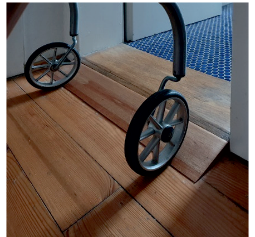
Fest verlegte oder mobile „Keile“ an Türschwellen erleichtern die Benutzung mit radgebundenen Hilfsmitteln
