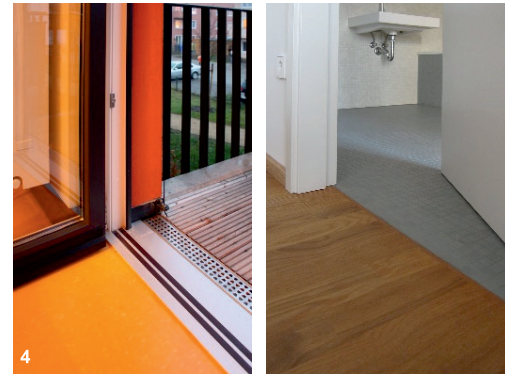
Niveaugleicher Übergang zum Freisitz (Außen) und zum Bad (Innen)
