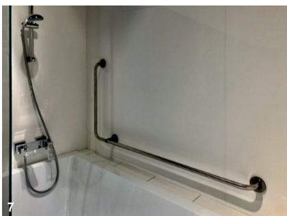
Wandmontierte Stütz- und Haltesysteme im Duschbereich und an der Badewanne
